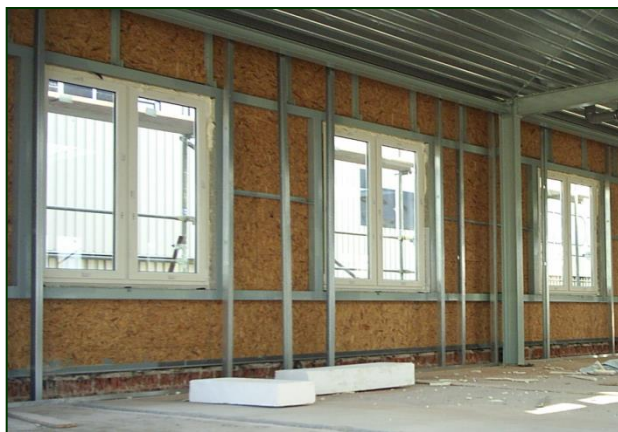
Обшивка каркасов строений
