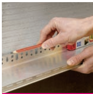
Рис. 9б Разметка линии установки
