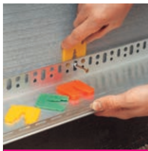
Рис. 9в Подкладка пластиковой шайбы
