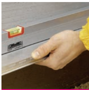
Рис. 9а Установка горизонтального положения при помощи уровня
