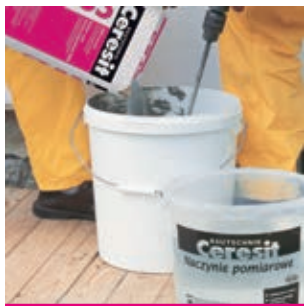
Рис. 11 Приготовление клеевой смеси Ceresit
