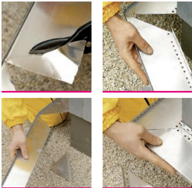
Рис. 10 Монтаж цокольной планки на углах здания
