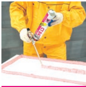
Рис. 17 Нанесение полиуретанового клея на теплоизоляционную плиту
