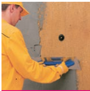
Рис. 40 Грунтование минераловатных плит
