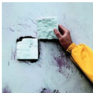
Рис. 6 Проверка прочности основания «на отрыв»
