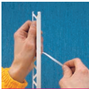
Рис. 26 Установка примыкающего профиля
