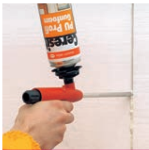
Рис. 21 Заполнение зазоров монтажной пеной
