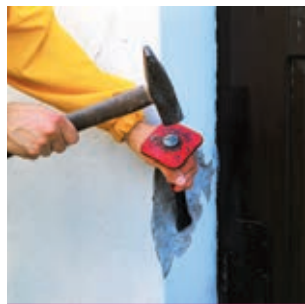
Рис. 2 Удаление непрочных участков основания с помощью зубила
