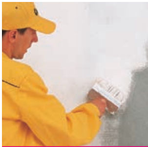
Рис. 44 Грунтование базового армирующего слоя
