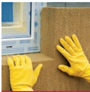
Рис. 25 Установка утеплителя на откосах
