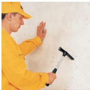
Рис. 1 Удаление непрочных участков основания молотком
