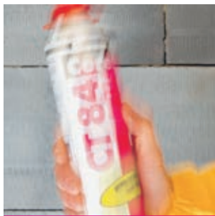
Рис. 12 Встряхивание баллона
