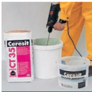
Рис. 45 Приготовление декоративных штукатурок
