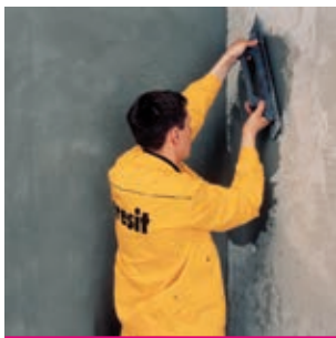
Рис. 8 Выравнивание
