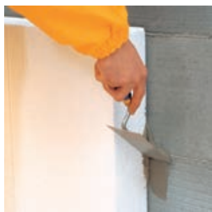
Рис. 22 Удаление излишков клеевого состава
