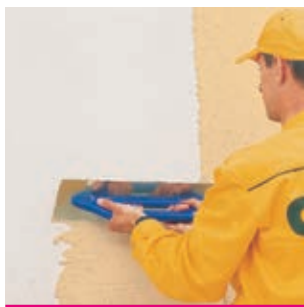
Рис. 47 Нанесение декоративной штукатурки на основание
