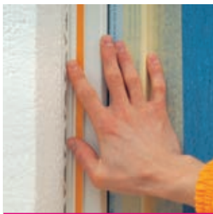
Рис. 26 Установка примыкающего профиля
