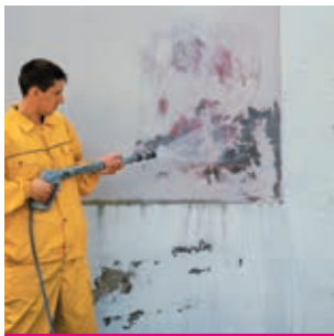
Рис. 3 Очистка основания моечной машиной
