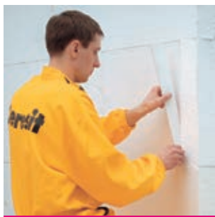
Рис. 20 Заделка открытых швов
