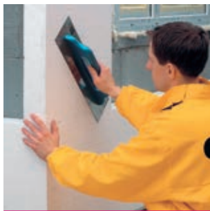
Рис. 18 Установка плит в проектное положение
