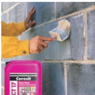
Рис. 7 Грунтование основания
